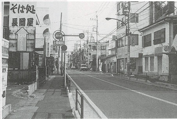
平成9年12月 相南1丁目2番地道路整備後
