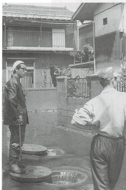
下水道集中処理場付近
